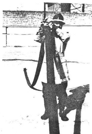
تخلیه آب لوله روی شانه
